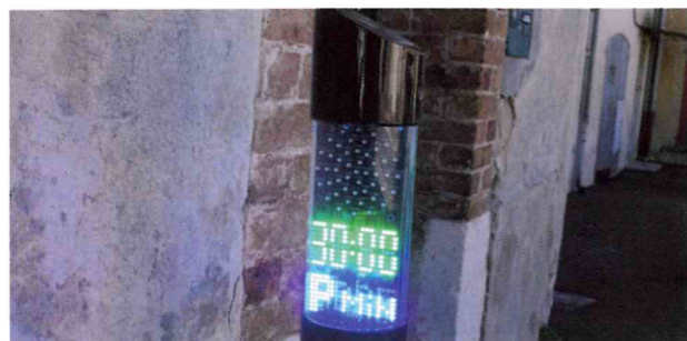
INSTALLATION D'UNE BORNE DE STATIONNEMENT TEMPORAIRE
