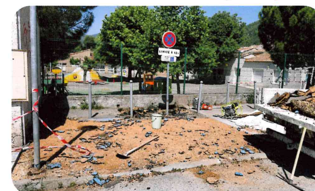
Travaux d'accessibilité devant l'école maternelle
