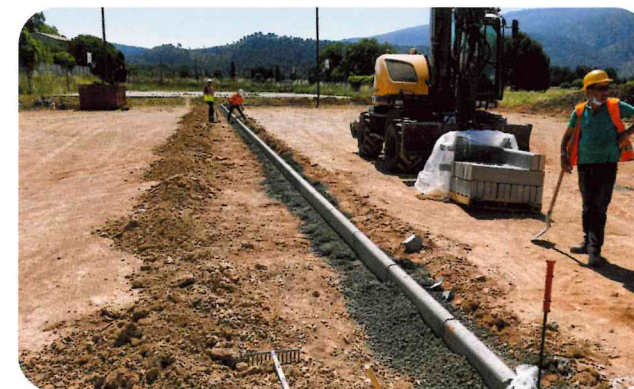
Terrassement du City Stade
