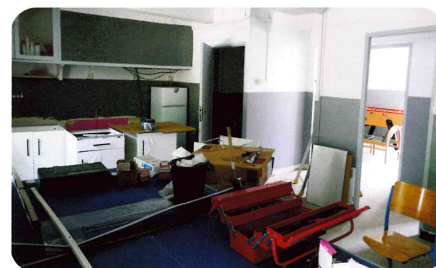
Travaux de rénovation au centre de loisirs «La Magadala»
