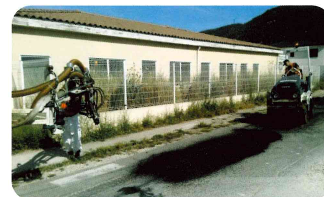
Travaux de goudronnage chemin de la Roque, Sainte Catherine et la Curasse
