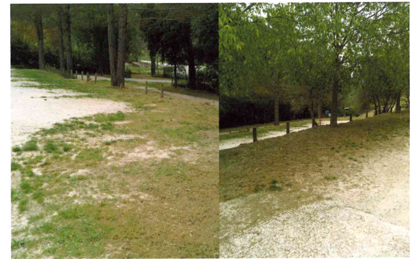
Aire de camping-cars après les travaux.
