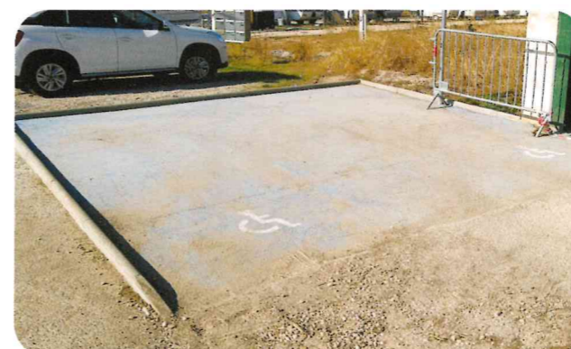
Travaux place de parking PMR devant le stade
