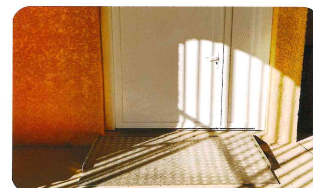
Travaux d'accessibilité aux personnes à mobilité réduite au stade
