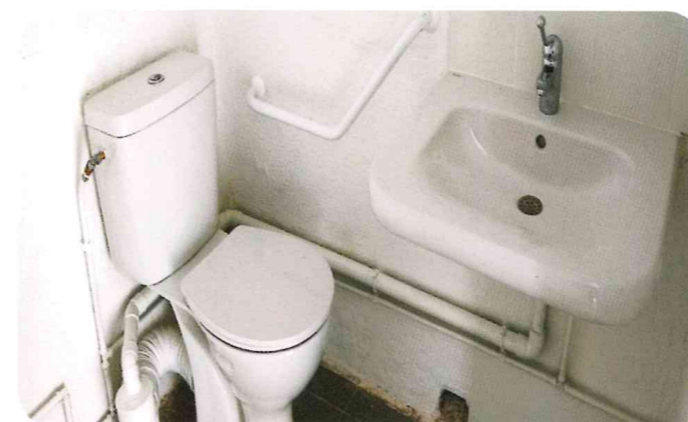
Travaux toilettes pour personnes à mobilité réduite au stade
