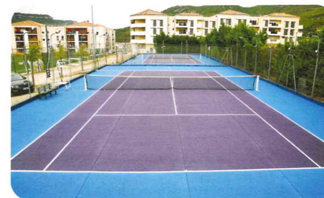
Travaux de peinture au stade de tennis
