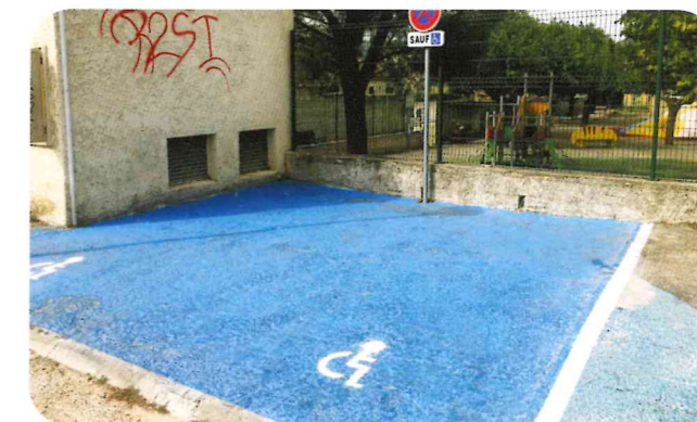
Travaux place de parking PMR devant la maternelle
