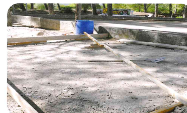
Travaux place de parking PMR au boulodrome
