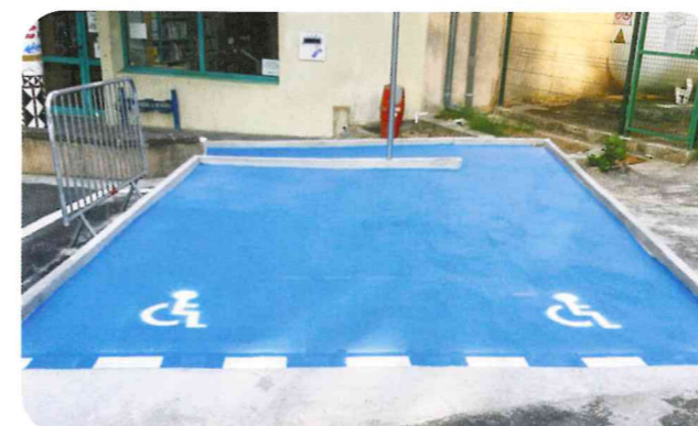
Travaux place de parking PMR devant la médiathèque
