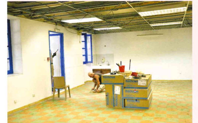
Rénovation d'une salle pour l'ouverture d'une nouvelle classe à la rentrée
