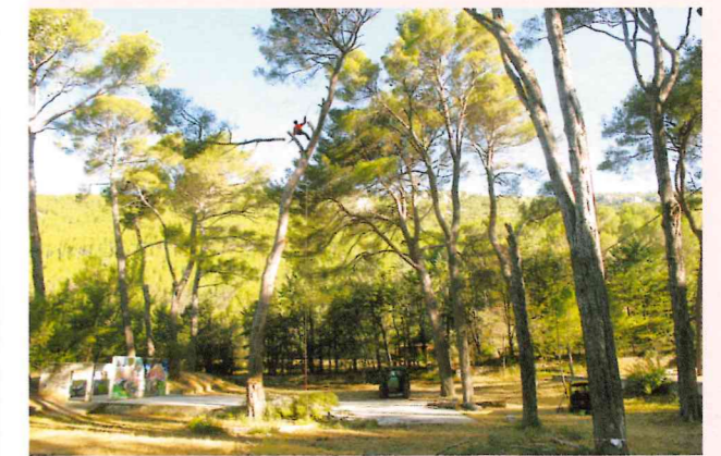
Mise en sécurité du jardin de la ville avec abattage coupe des arbres et propreté
