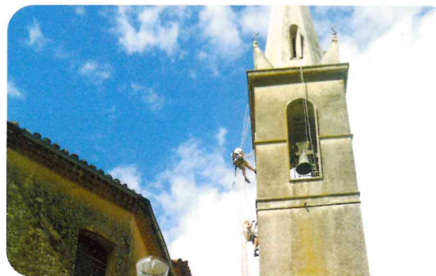
Travaux de désinfection du clocher de l'église
