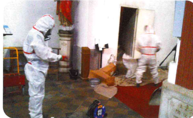
Travaux de désinfection du clocher de l'église
