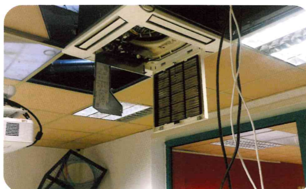
Travaux de remplacement de la climatisation à la médiathèque
