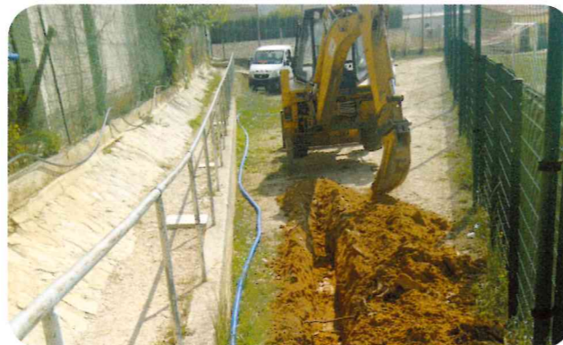
Travaux de remplacement d'une conduite d'eau
