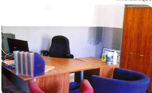
Travaux de rénovation de la Magdala
