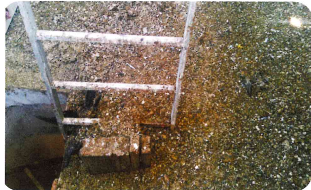
Travaux de désinfection du clocher de l'église
